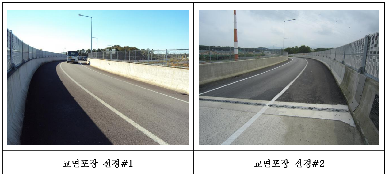
【사진 20.3.17】 교면포장 전경
