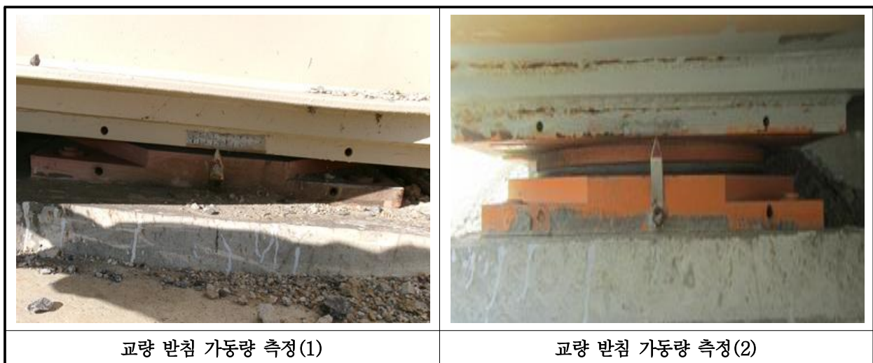
【사진 20.3.13】교량받침 이동량 측정
