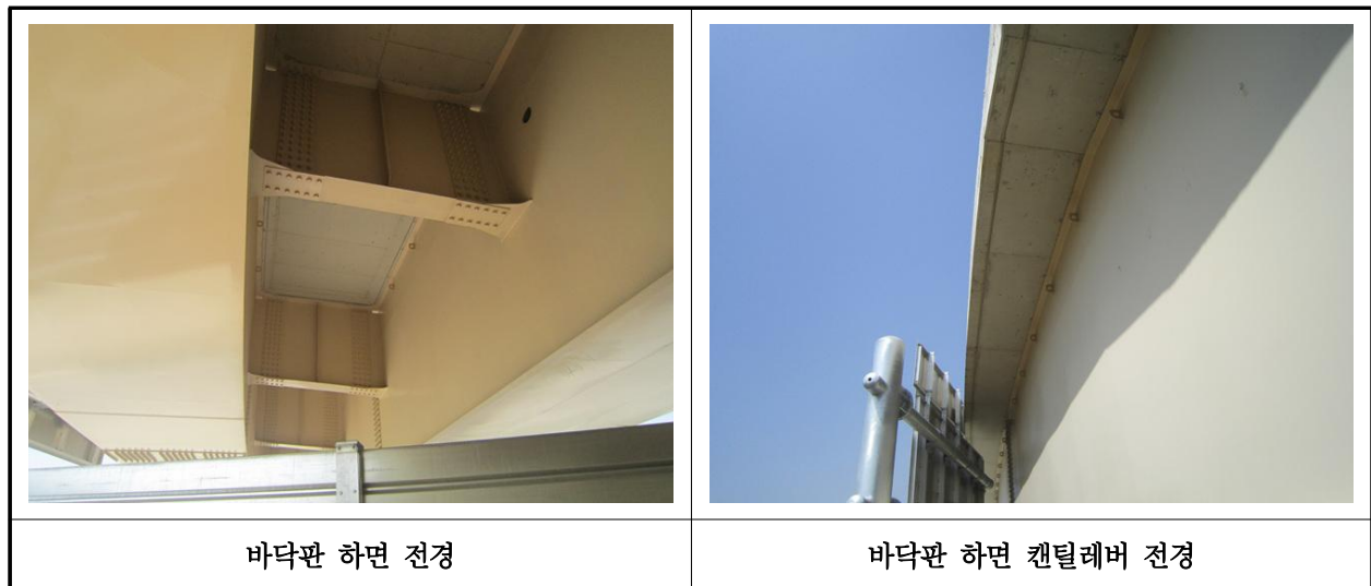
【사진 20.3.2】 바닥판하면 전경
