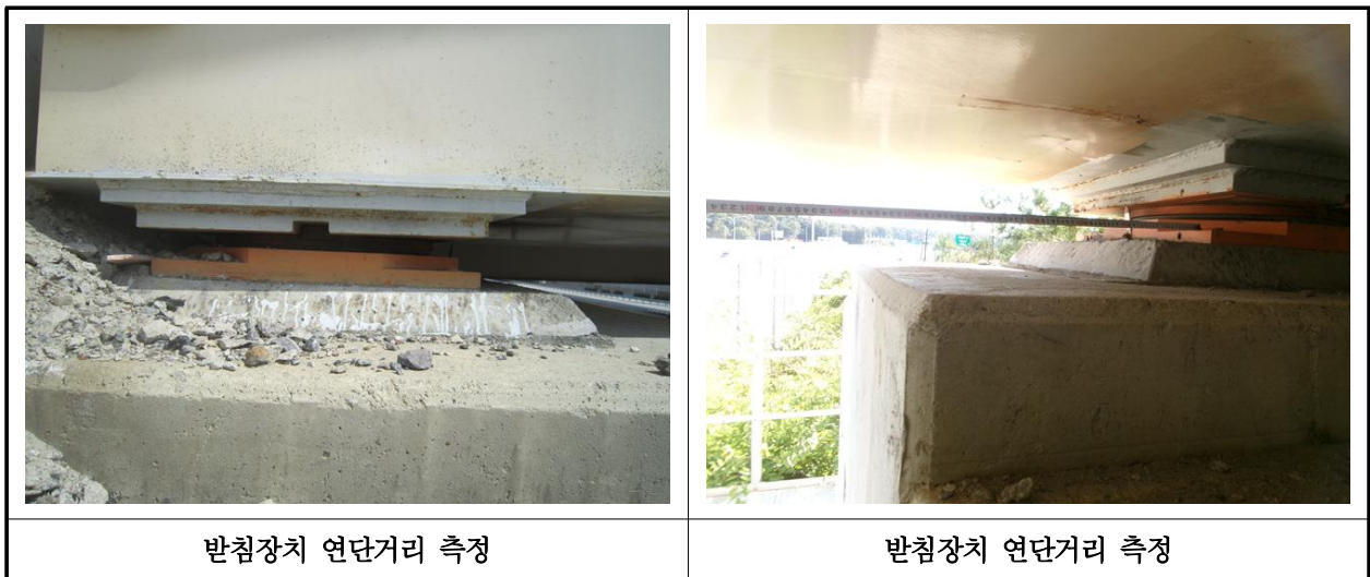
【사진 20.3.12】 교량받침장치 연단거리측정
