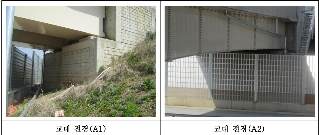
【사진 20.3.8】 교대 전경
