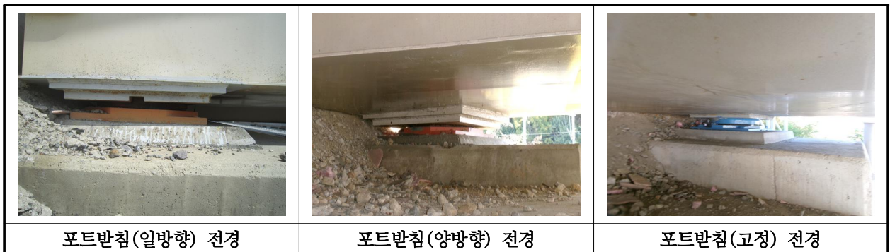
【사진 20.3.10】 교량받침 전경
