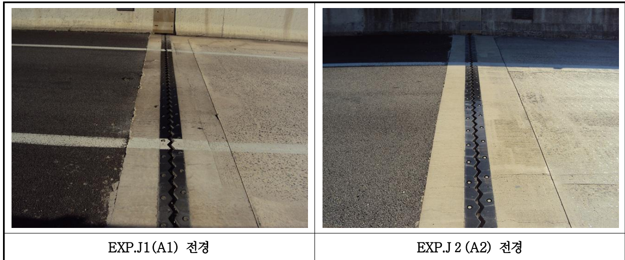
【사진 20.3.14】 신축이음장치 전경
