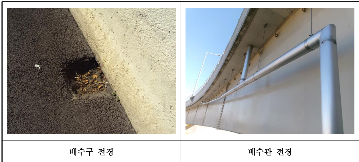
【사진 20.3.19】 배수시설 전경
