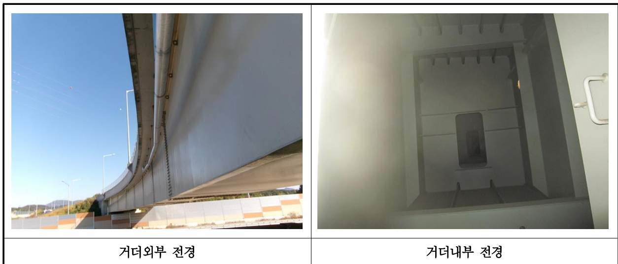
【사진 20.3.4】 거더 전경
