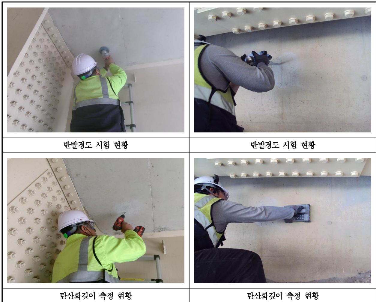
【사진 20.4.1】 콘크리트 내구성조사 현황
